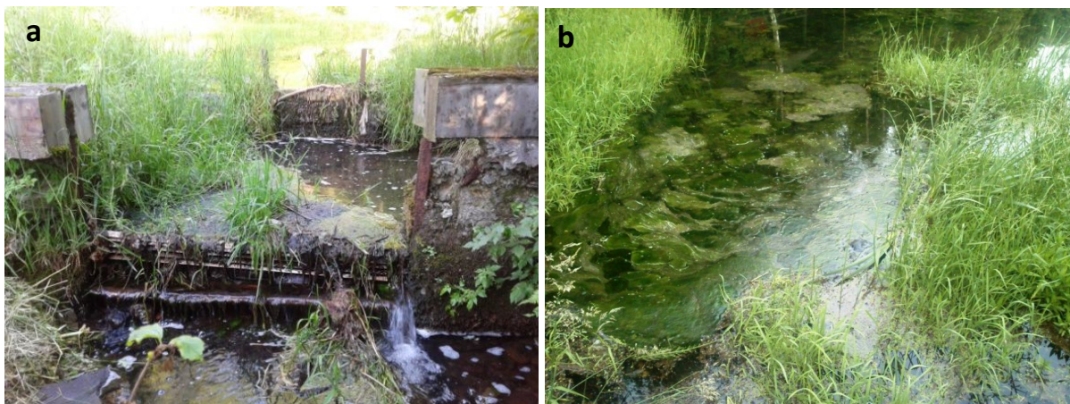
Obr.1. a) Dvojité betonové stavitko na odtoku nádrže určené k opravě b) vodní hladina nádrže s porostem řas a travin, foto: červen 2017.
