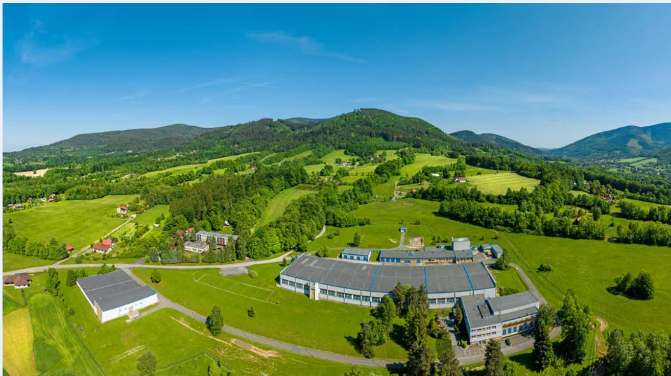
Úpravná vody Nová Ves nad Frýdlantem nad Ostravicí. Největší provoz svého druhu v Beskydech, který odebírá surovou vodu z údolní nádrže Šance vybudované na řece Ostravici nad stejnojmennou obcí.
