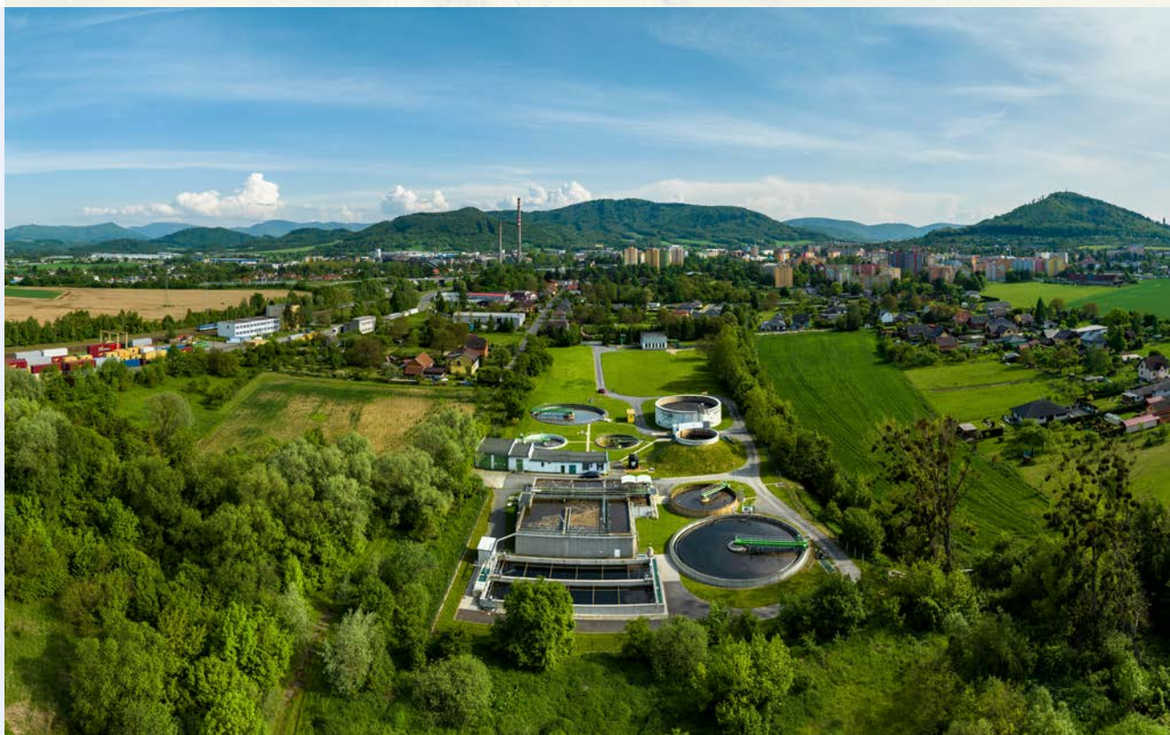
Čistírna odpadních vod v Kopřivnici. Aktuálně prochází modernizací kalové hospodářství. Před dvěma lety zde byla vybudována za 38 milionů korun nová dosazovací nádrž, čímž došlo ke zvýšení kvalitativních parametrů vyčištěné vody.
